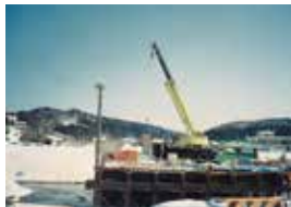
「下保倉橋架替」工事の様子
