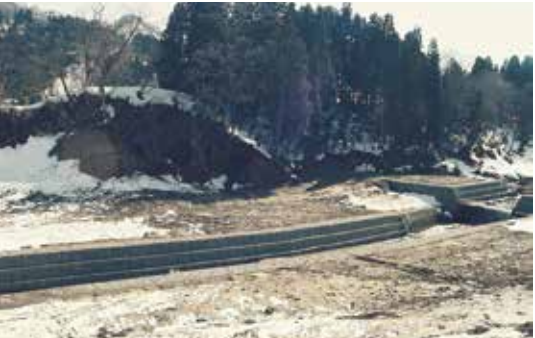
1997年(平成9年) 堀切川通常砂防(荒廃)工事
