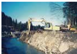
「堀切川通常砂防(荒廃)工事」 工事の様子
