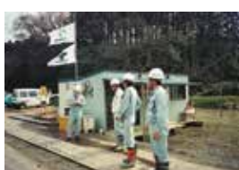
「日253号(三和安塚道路)一般国道 軟弱地盤改良工事」現場事務所
