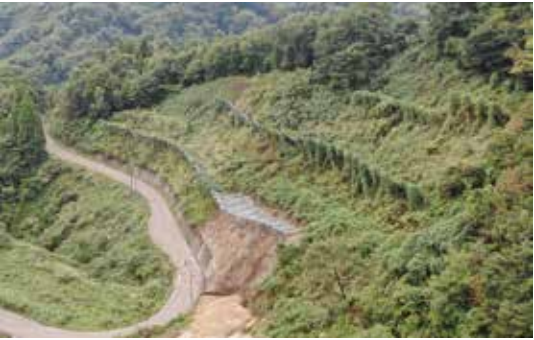
2024年(令和6年) (主)大潟高柳線 防災安全(雪寒・補正)雪崩予防柵設置工事
