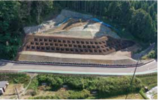
2021年(令和3年) 牧地区県営地すべり対策事業第2-6次工事
