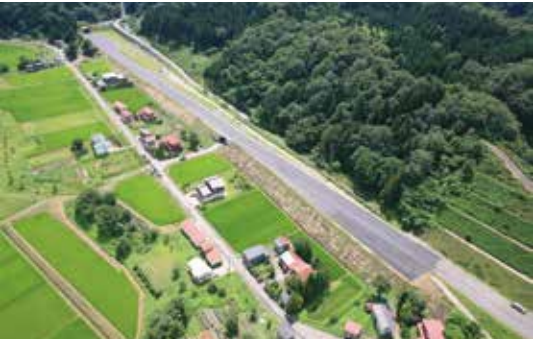
2008年(平成20年) 日253号(三和安塚道路)地域連携国道改築桜島工区舗装工事
