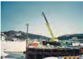
「下保倉橋架替」工事の様子
