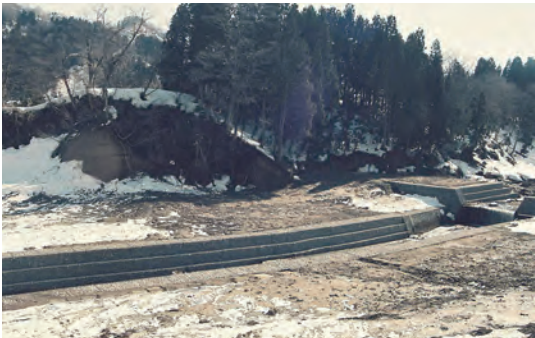
1997年(平成9年) 堀切川通常砂防(荒廃)工事
