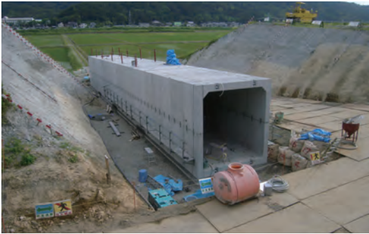
2007年(平成19年) 日253号地域連携(国道改築)山本農道ボックス工事
