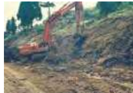
「農免農道事業川平地区第3次工事」工事の様子
