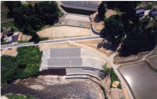
2003年(平成15年) 牧第2地区第14-2次工事、牧第2地区第15-1次工事
